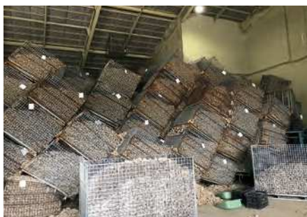
地震被害を受けた馬鈴薯倉庫
